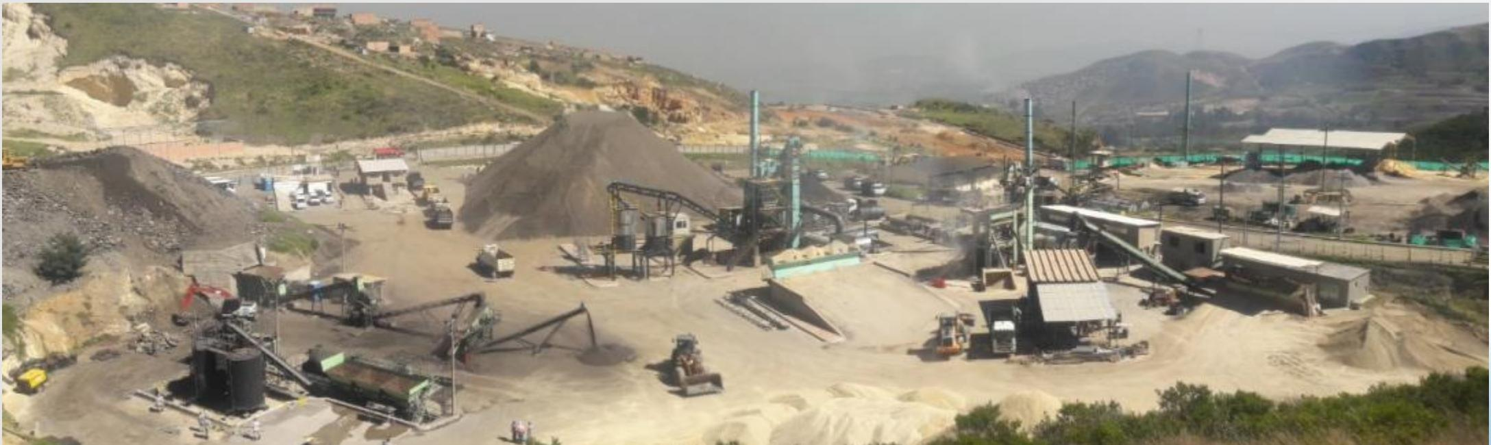
Montaje de la Unidad de Mantenimiento Vial de Bogotá D.C. ubicado en la localidad de Ciudad Bolívar, donde producen mensualmente un promedio de 25.000 m<sup>3</sup> de mezclas en frio utilizando RAP.
